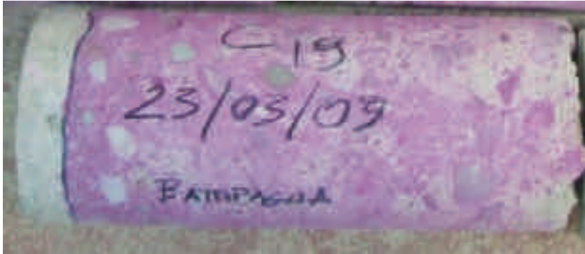
Determinazione della profondità di carbonatazione.
