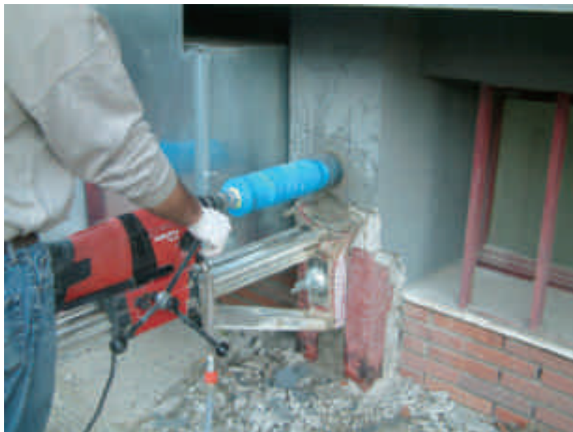
Prelievo di CLS mediante carotaggio.
