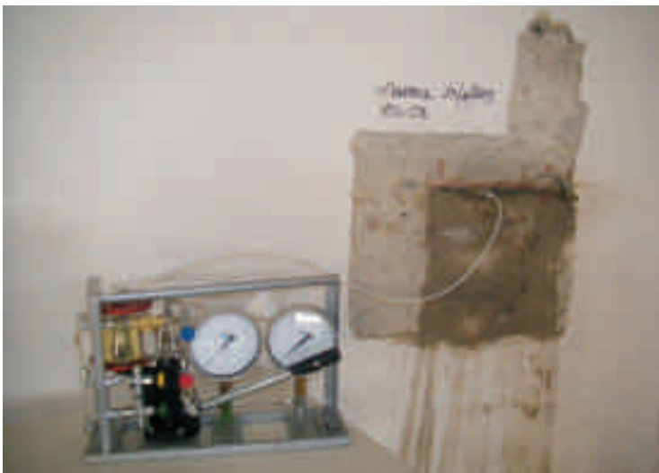
Prova con martinetti Singolo eseguita presso la sede Comune di Amatrice Corso Umberto I, 70 - Amatrice (RI)
